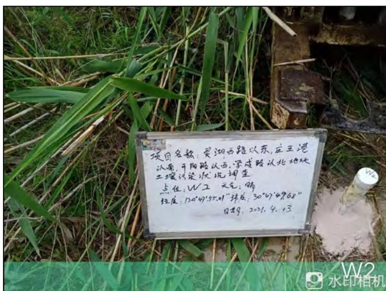
图 5.2-6 膨润土和水泥密封现场照片
